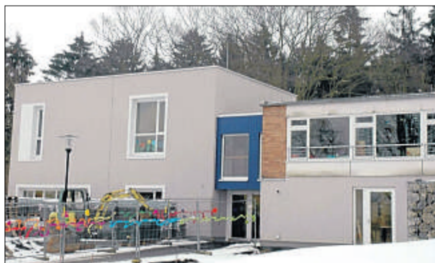
Der Außenbereich ist noch Baustelle: Der Anbau der Außenstelle Lindenberg der Fricke-Schule ist an der frisch verputzten, zartrosa leuchtenden Fassade erkennbar. Das neue Treppenhaus (Mitte) ist blau abgesetzt.
